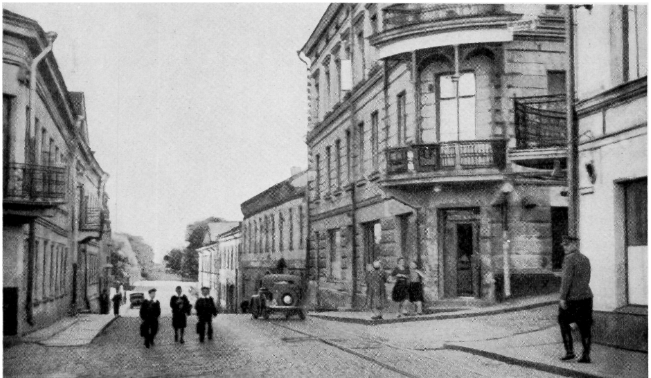
Linnankatua. Vasemmalla Pamppalankadun nurkkaus, taustalla Buttenhoffin talon torni. Oikealla keskipaikkeilla Dippellin talo.
