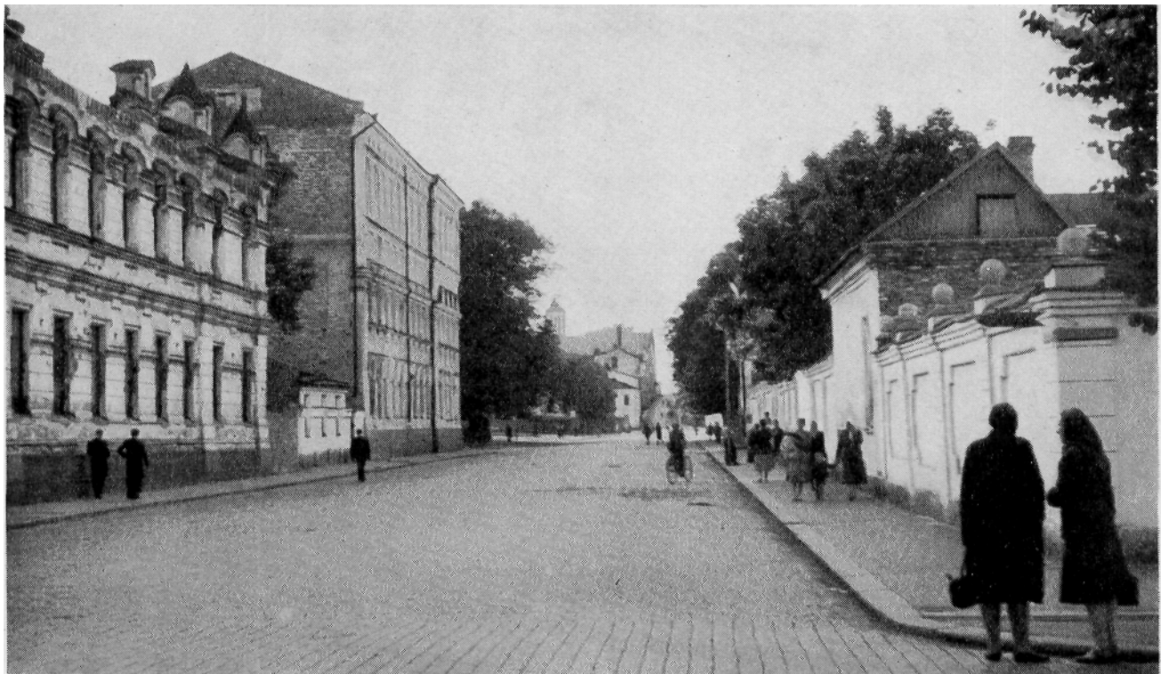
Linnankadun näkymä Paraatikentän seudulta. Oikealla Torikatua Viipurin Säästöpankin kohdalta ja vanha poppeli.
