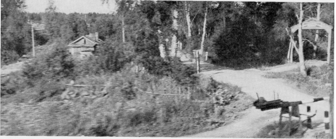
Tie haaraantuu Ykspään hoviin
