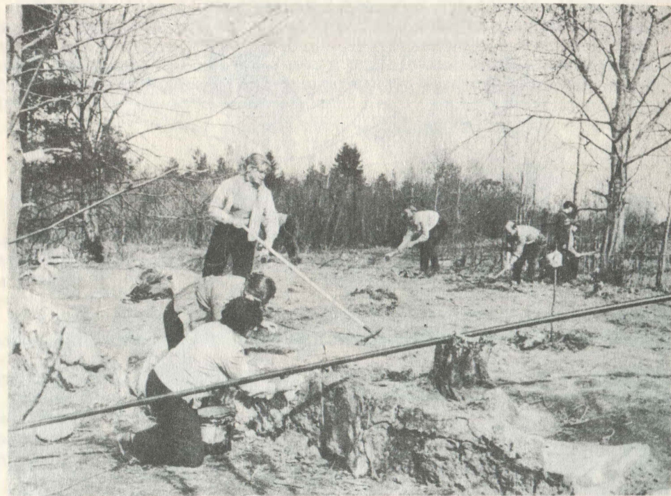
Расчистка участка и фундамента бывшей дачи В. Д. Бонч-Бруевича.
